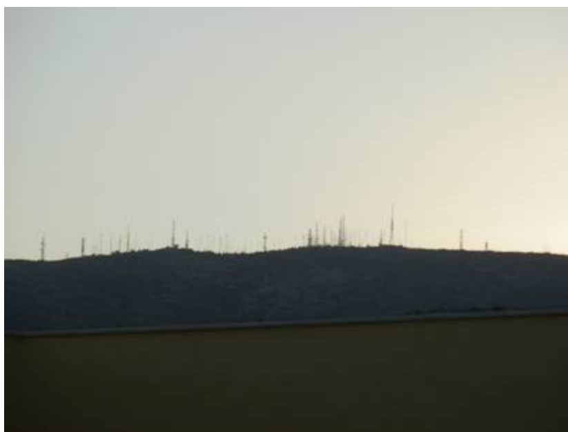
Σχήμα 15: Κεραίες εκπομπής ραδιοφωνικού και τηλεοπτικού σήματος στον Υμηττό.
